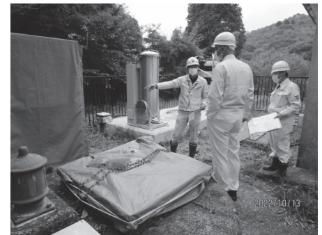
現地踏査 (追分水道施設膜ろ過装置設置工事)
