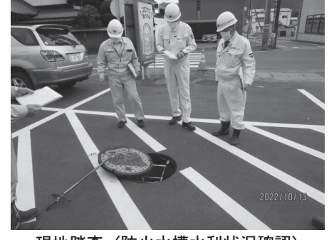
現地踏査 (防火水槽水利状況確認)
