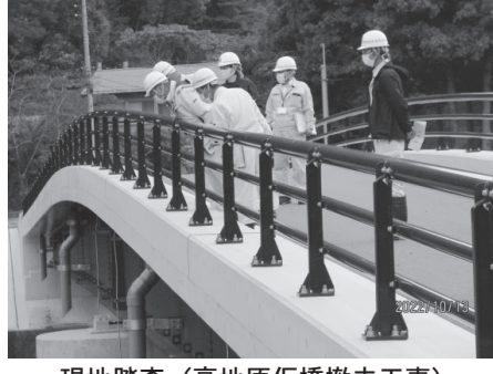
現地踏査 (高地原仮橋撤去工事)
