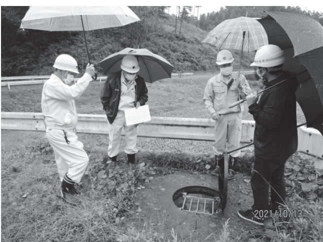
現地踏査（防火水槽水利状況確認）
