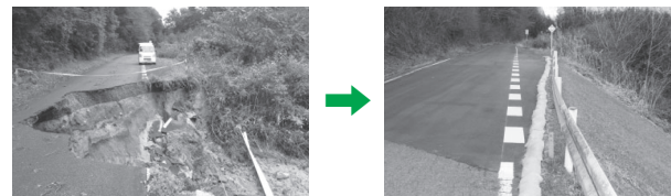
▲令和元年度林道大拱線災害復旧工事進捗状況
