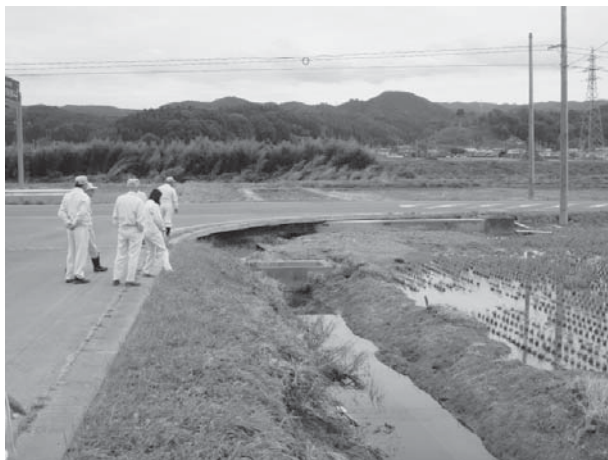
関岡地内土砂流入
