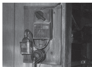
出火したものと同型のコンデンサ
