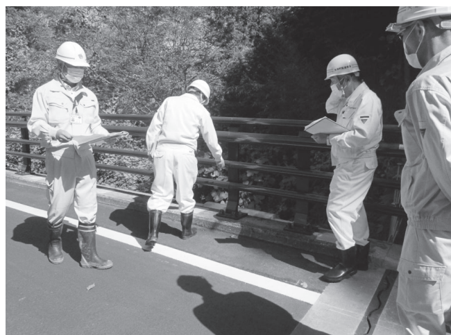
現地踏査（内川橋橋梁補修工事）
