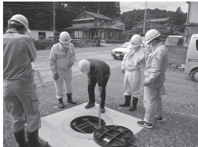
現地踏査（耐震性貯水槽設置工事）
