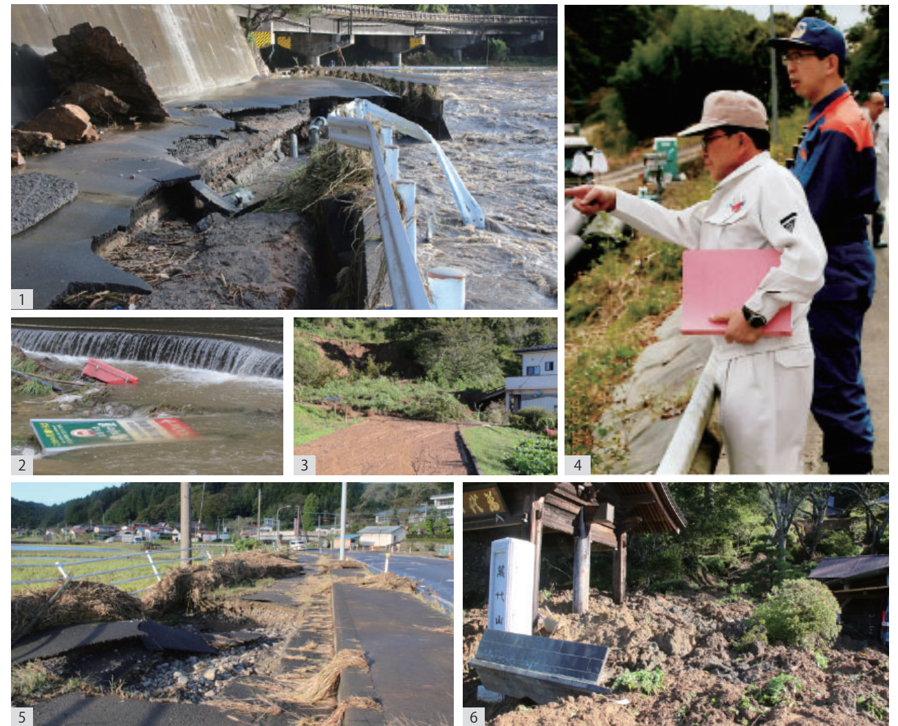
1_崩落した夢見橋付近の町道。/2_道路法面が崩れ冠水し、滝川の里の看板等が流された馬渡戸地域。3_土砂崩れが起きた来る里の杜。/4_現地視察に訪れ、高地原地区の現状と落橋した高地原橋の説明を佐川町長から受ける内堀県知事/5_久慈川の増水・氾濫等により崩れた関岡字鶯ヶ沢付近の歩道。6_入口まで土砂が押し寄せた東慶寺。
