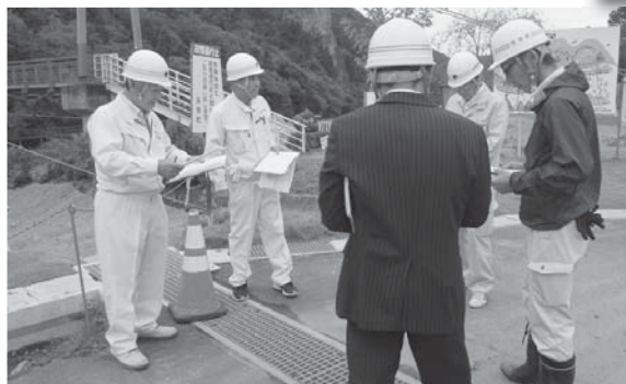
現場踏査（親水広場）
