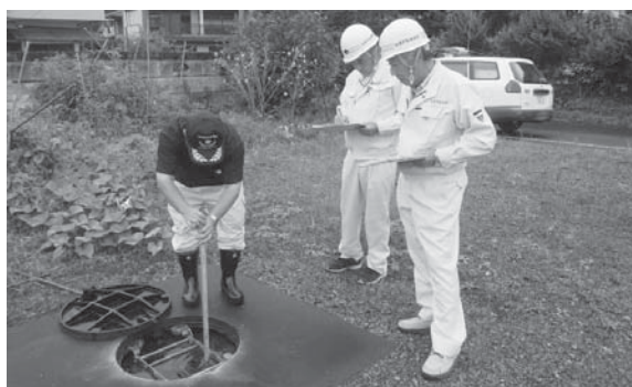
現場踏査（上関河内地内防火水槽）
