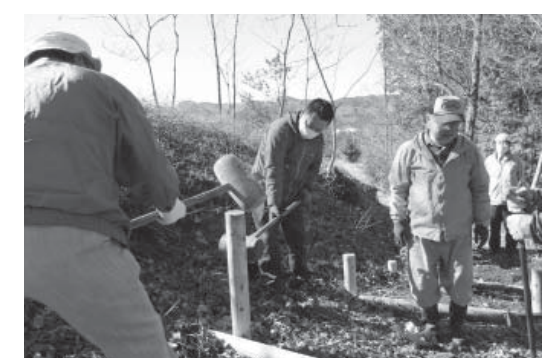
散策路（遊歩道）整備のための杭を打つ参加者
