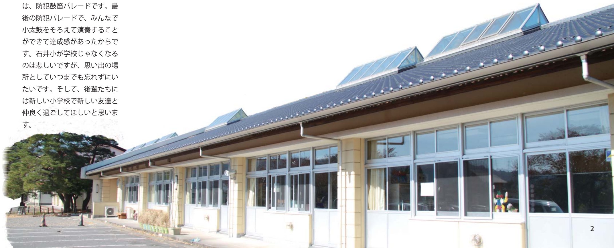
▶石井小学校校舎（平成15年～現在）
