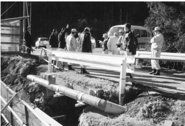
▶第2簡易水道配水管布設替工事
