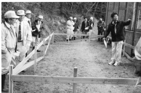
▲町営運動場本部棟建設工事
