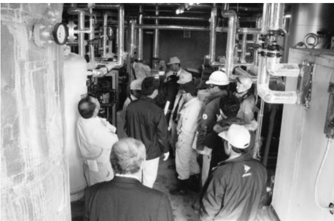
▲矢祭町温泉交流センター改修工事（ボイラー室）
