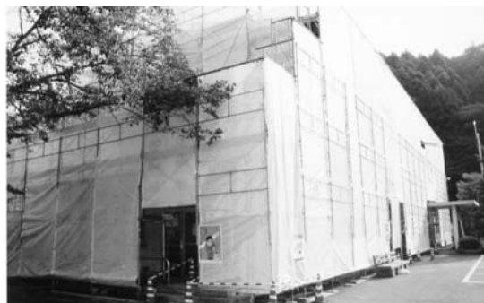
工事中の役場庁舎
