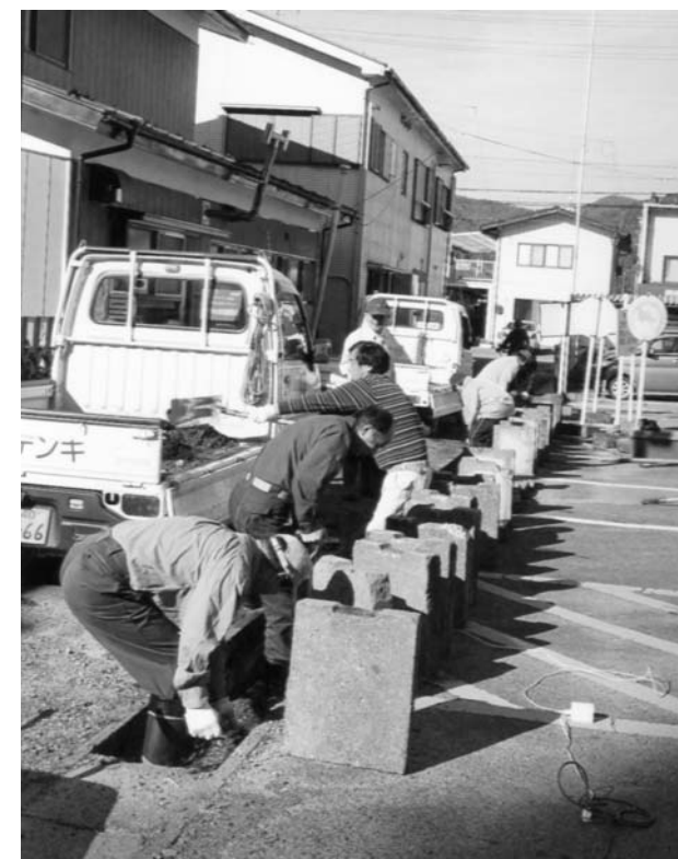
U字溝の土砂払い
