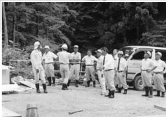
トンネル工事現場を視察する一行
