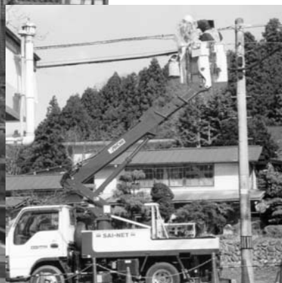
急ピッチで行われたケーブル工事
