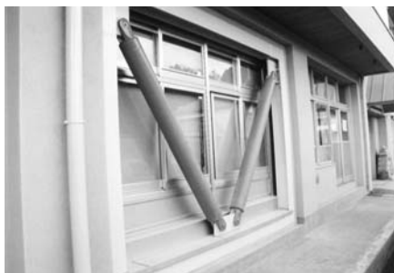
校舎窓枠に施行した耐震補強材
