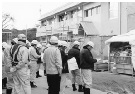
中学校の大規模改造工事を視察
