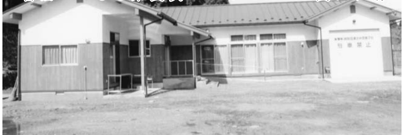
〈完成した集会施設〉
