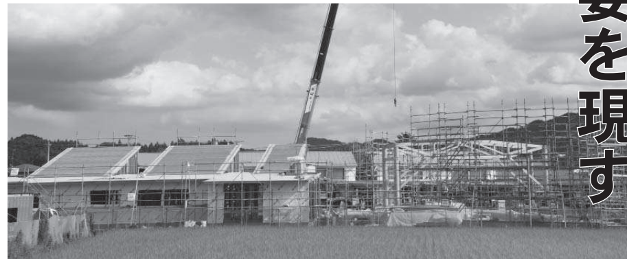
北側から望む園舎（左手前が保育部棟、奥が幼児教育部棟、右側が遊戯室棟）
