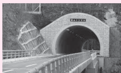
東山トンネルと舟ヶ沢橋
