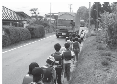
国道349号道路改良 【小田川～上関河内地内】
