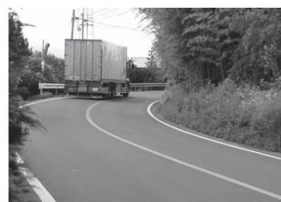
国道118号道路改良 【東館字山野井地内】
