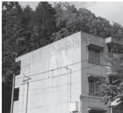
東館団地の外観
