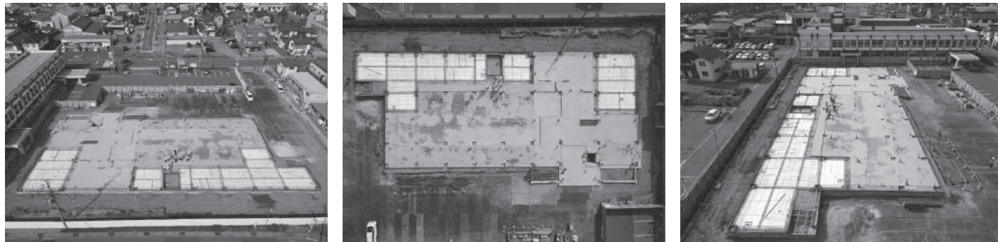
ピット（地中梁に囲まれた空間、縁の下のこと）の上にコンクリートを打設するための型枠及び断熱材を設置している状況です。
