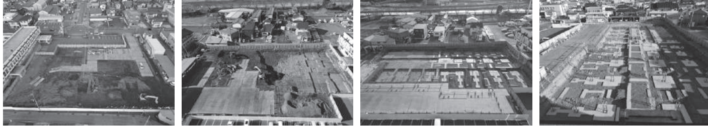
通路鉄板を敷きながら、掘削を開始した状況です。掘削を進めながら、床付け、基礎砕石を行っている状況です。2工区に分けて、基礎下の均しコンクリートを打設している状況です。柱脚を取り付けしている状況です。
