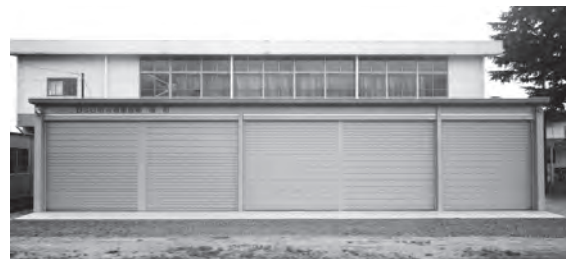
配備した防災倉庫
