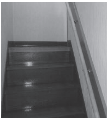
手すり設置工事後
