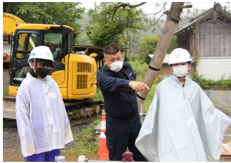
片貝の工事現場を見学 (スズキ建材)
