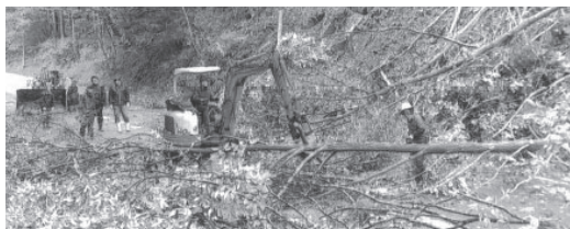
重機を使った作業中
