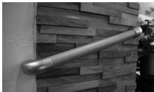
手すりの取り付けも対象です
