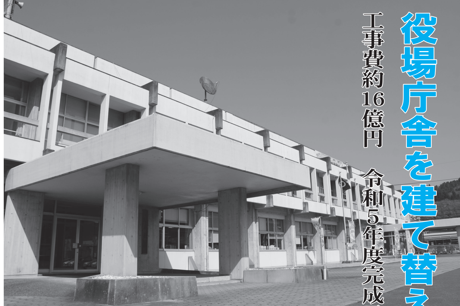
築50年が過ぎ耐震性が不足している庁舎
