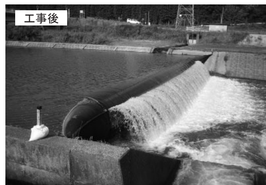
完成した守崎堰 ゴムが膨らんでいる
