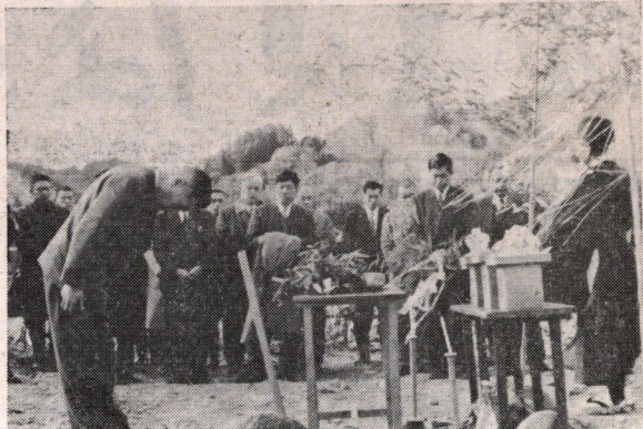
写真・久慈川橋起工式
