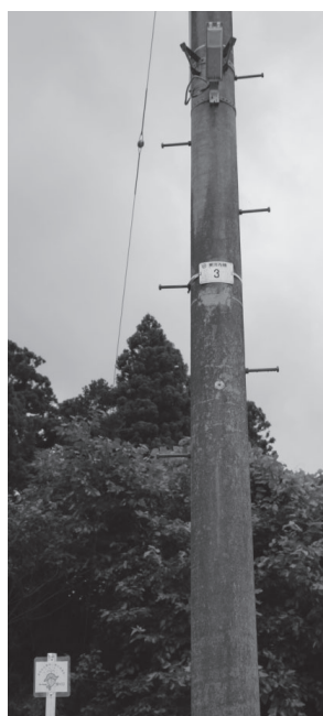
整備されたLED防犯灯
