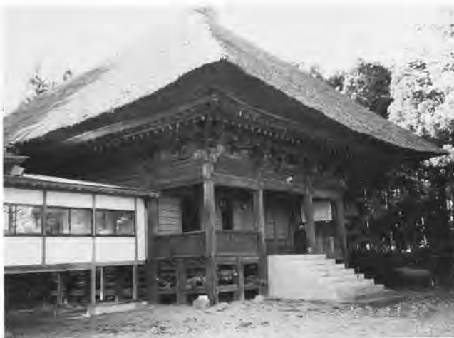
薬王寺薬師堂外観
