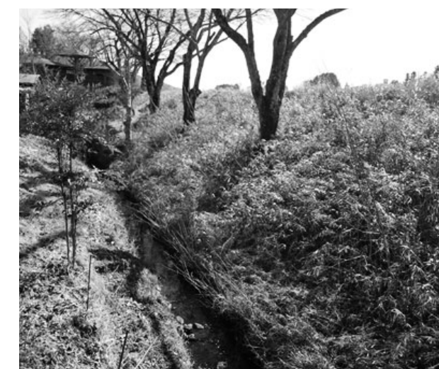
水路整備が必要な大字埴地内土掘り水路
