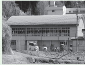
小学校体育館 窓枠改修工事 5,137万円
