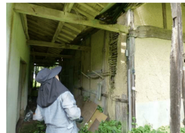
外壁の浮きの発生の有無やはりの変形や破損状況等について、建築士が町の担当職員と一緒に確認
