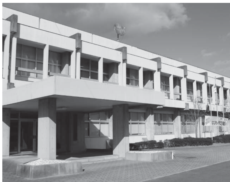
建設から約半世紀が経過する役場本庁舎
