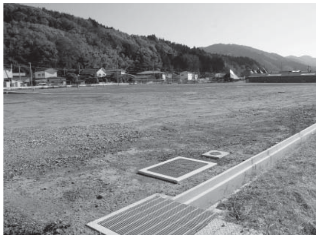
造成工事が完了したはなわこども園（仮称）建設予定地（材木町）
