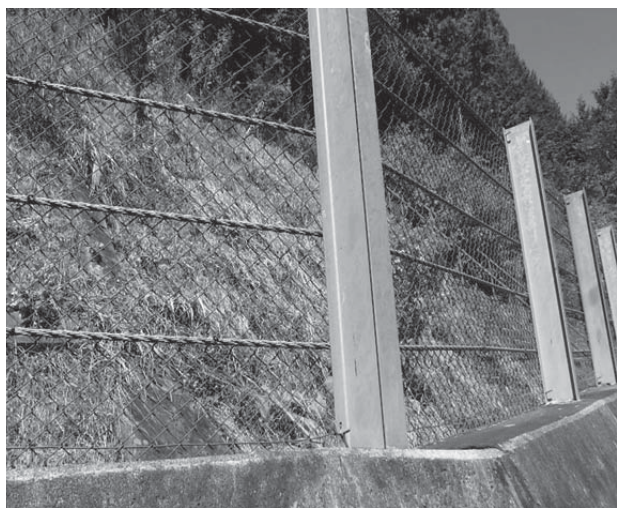
那倉地内の急傾斜地
