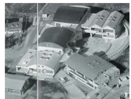
平成4年に完成した小学校新校舎
