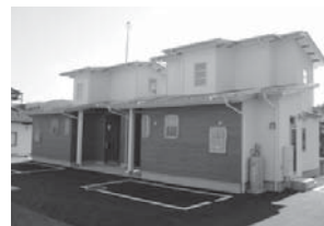
定住促進住宅外観
