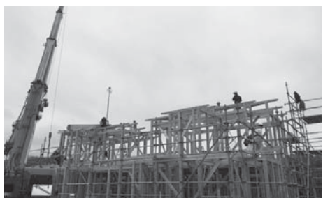
建設中の定住促進住宅
