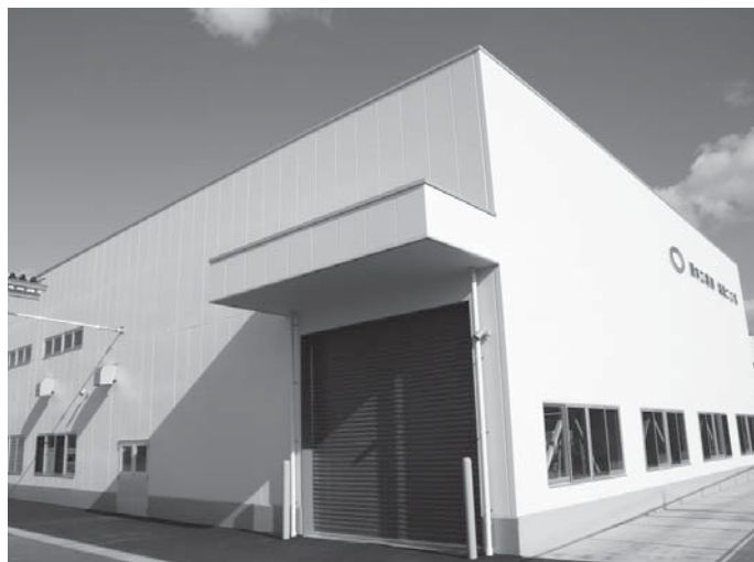
第2工場第2棟は、4月5日(火)から本格稼働しました
