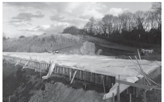
実証実験施設予定地
