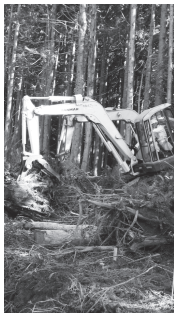
作業道を整備
