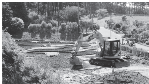
工事中のダリア園
