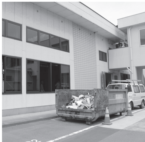
改修中の福祉会館
