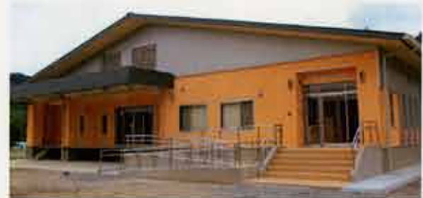
【埴町学校給食センター（大字竹之内字草田）】 鉄筋造2階建。延床面積816.28㎡で、建設費は約3億8,800万円。1,000食の給食を賄うことができ、またドライシステムにより、室温25℃以下、湿度80%以下という安定した空調管理が可能になりました。（平成27年6月8日完成）
