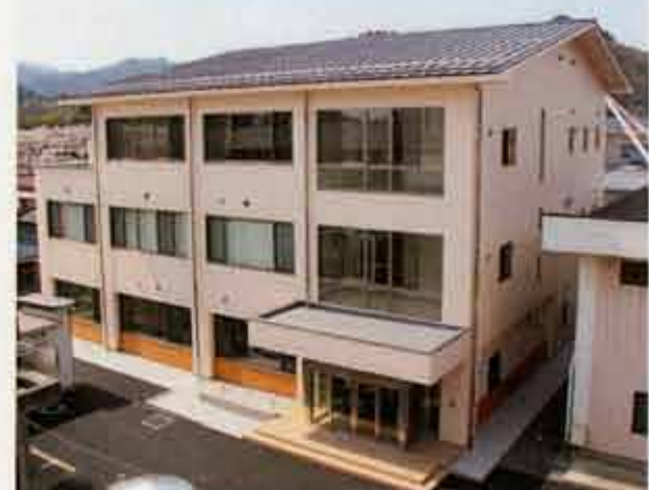
【埴町防災センター（大字埴字大町三丁目）】 鉄筋コンクリート造3階建（一部2階）。延床面積1,089㎡で、建設費は約3億6,000万円。大規模災害を想定した耐震強度、災害対策本部室や、非常用電源設備を完備しています。（平成27年3月31日完成）
