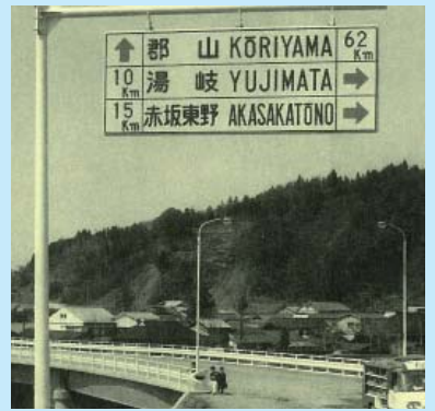
昭和40年 完成した埴大橋
