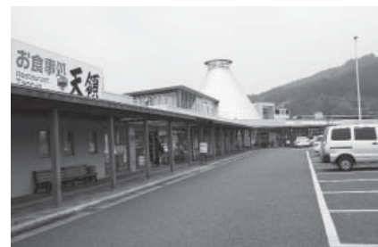
湯遊ランドはなわ(上)と道の駅はなわ(下)へ太陽光発電設備を設置します
