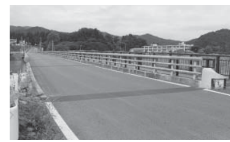
補修工事が行われた米山橋
