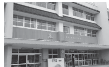
エアコンが設置された埴小
