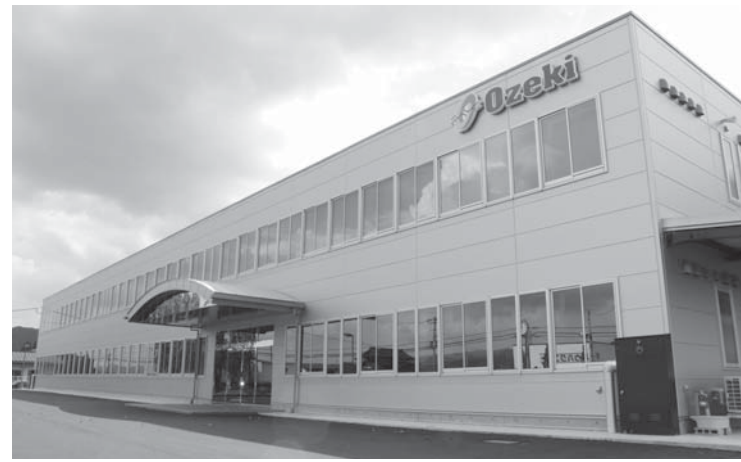
▲完成した福島新工場(旧高城小学校跡地)
