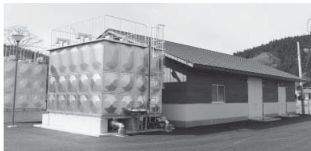
▲昨年度完成された「埴第一水源浄水場」 今年度は送・配水管の整備を予定しています
