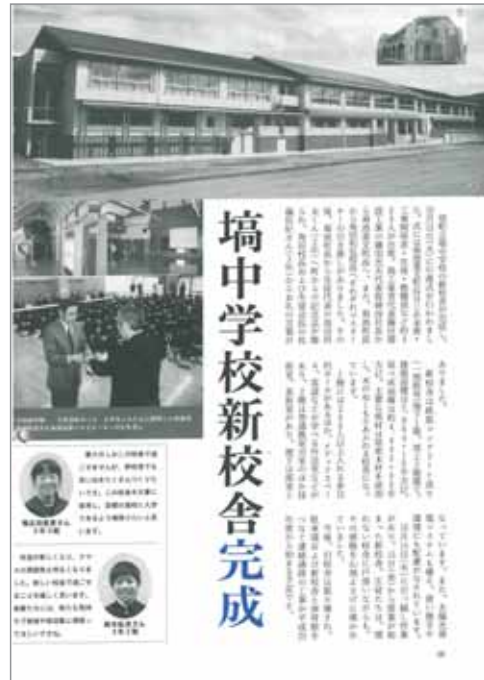
■平成22年11月号 (No.564) 塙中学校新校舎が完成。木のぬくもりあふれる校舎です
