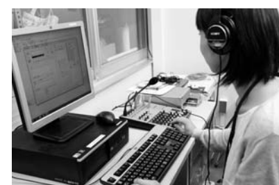
IP告知システム（役場内にある管理装置）
