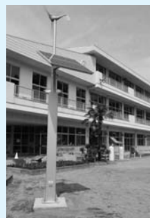
風力発電機と太陽電池で発電するLED照明灯
